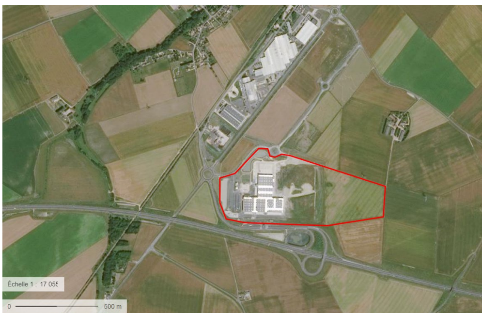
Figure 2 : Situation du terrain
